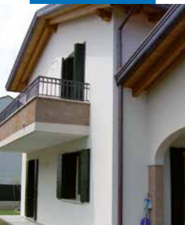
Reggio Emilia - Italien - Renovering af et privat hus ved brug af Mapetherm AR1 GG
