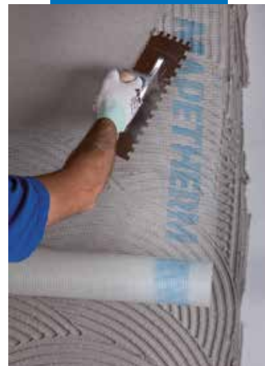
Påføring af et forstærkende udjævnings- og afretningslag med indlejring af glasfibernet; Mapetherm Net
