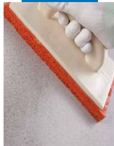
Overfladen på udjævnings- og afretningslaget glattes med et svampebræt
